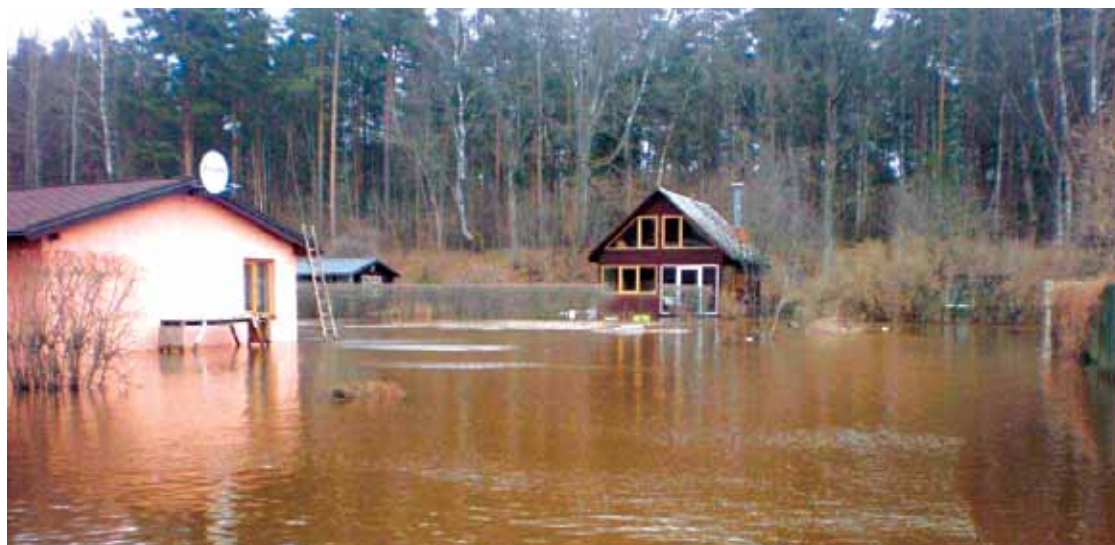
Upeslejās, Ābeles ielā, plūdu laikā 2011. gada aprīlī
