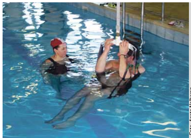
Speciālais pacēlājs nodrošina personas drošu un vieglu iekļūšanu ūdenī un izcelšanu no tā.
