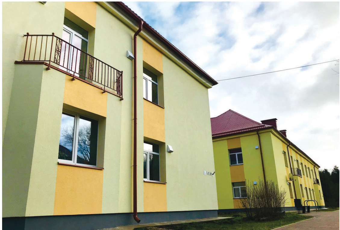
Vangažu pilsētas, Gaujas ielas 4. un 8. Numura nami tika renovēti 2019. gadā.
