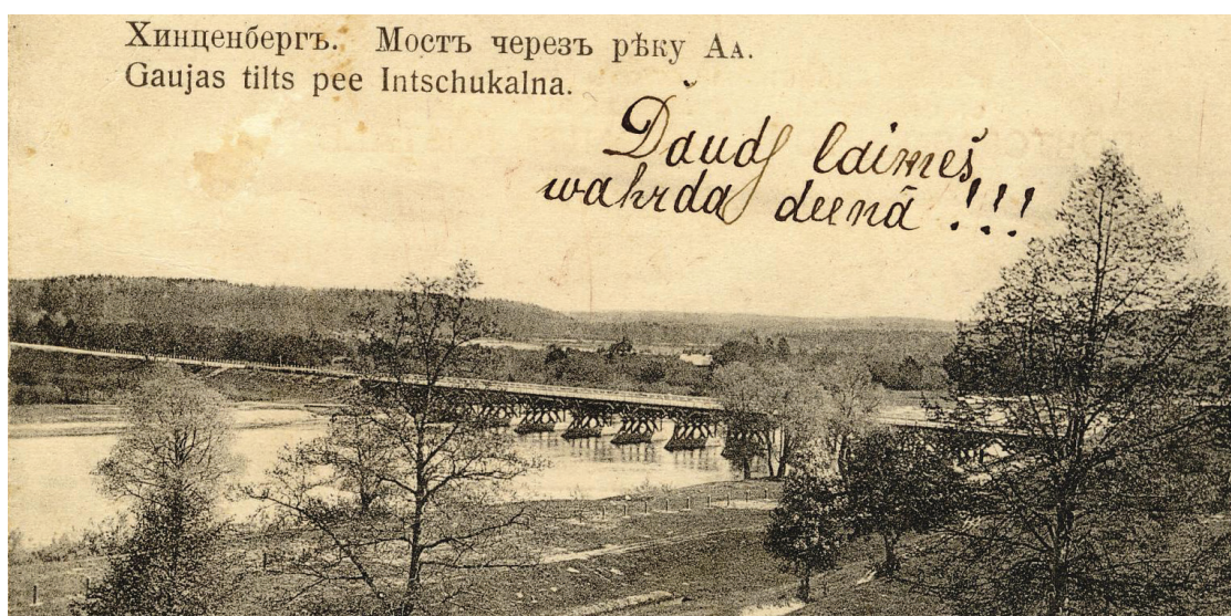
1920. gadā uzbūvēts Latvijā garākais koka konstrukciju atgāžņu sistēmas tilts pāri Gaujai.
