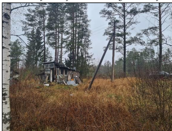
Skats uz Vērtējamo Objektu / mazēka / elektrisko gaisvadu līniju stabs
