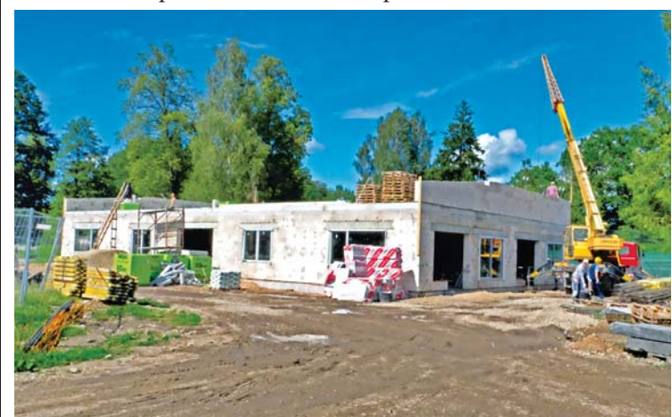
Darbmācības ēka būvniecības procesā
