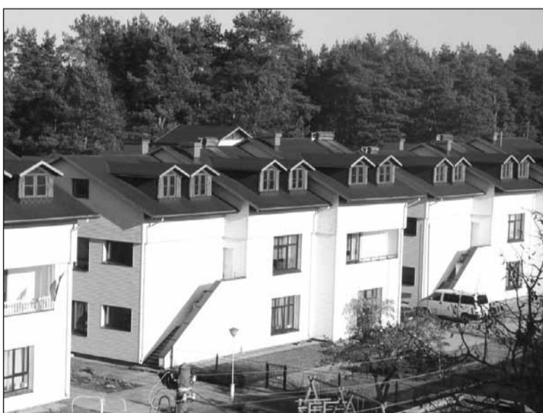
Sociālās aprūpēs māja „Gauja”, Inčukalns. Kolektori uzstādīti 2009. gadā.
